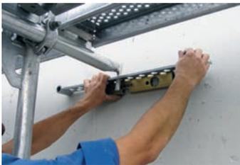
**Entweder** durch das Traversenrohr die Bohrungsstelle markieren
