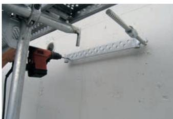
Durch das in der Traverse vorhandene kleine Loch, die Bohrstelle markieren, bohren und Dübel setzen.
