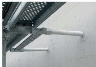
Mit der inneren Mutter wird der Traversen-Wandabstand eingestellt.
