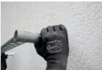
Ankertraverse und Ankerstäbe demontieren. Sollte sich die Traverse verklemmt haben, kann sie mit Hilfe der Muttern von den Ankerstäben gedrückt werden.
