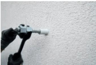
Zur Demontage der Ankerstäbe werden die Muttern gekontert,
