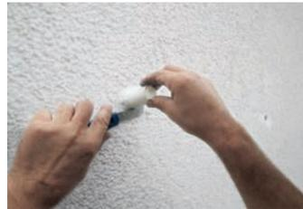
Der Schlauchüberstand wird bündig mit der Wand abgeschnitten.
