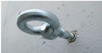
Ringmutter DIN 582 M12 auf Stockschraube aufdrehen.
