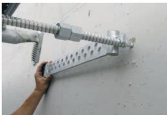
Das zweite Ankerloch kann über den Anriss oder die in der Traverse vorhandene Bohrschablone exakt positioniert werden. Dazu wird die Traverse mit dem Haken auf den vorhandenen Ankerstab aufgelegt und
