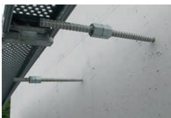
Zweiten Ankerstab setzen.
