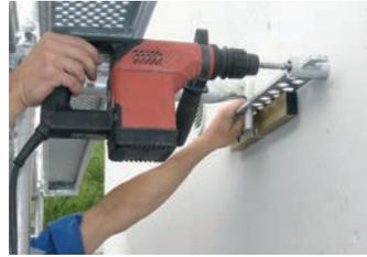
**oder** die Stelle anbohren. Eine weitere Möglichkeit ist es, die Achsmaße der Traverse anzuziehen (600 mm bzw. 420 mm)
