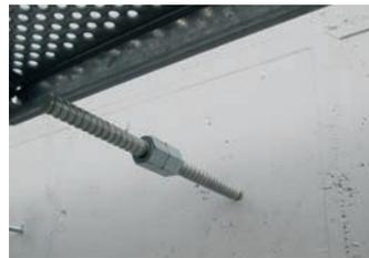
Stockschraube mit Hilfe des Ankerstabes in den Dübel schrauben. Hierzu zwei gekonkretierte Muttern SW 36 auf den Ankerstab aufschrauben und mit Gabelschlüssel die Stockschraube eindrehen.
